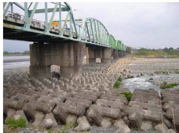
図－4 橋脚防護工の事例（富士川）
