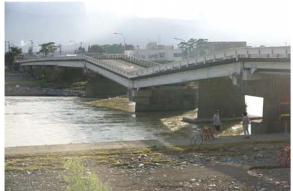
図－3 橋脚周辺の洗掘による橋脚の沈下（神奈川県、酒匂川）
