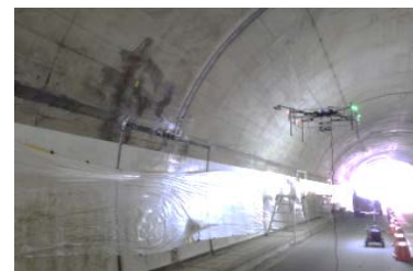
写真 5. トンネル吹付状況
