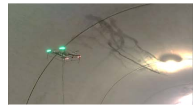
写真5. 天井方向吹付け状況
