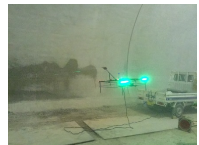
写真4. 壁方向吹付け状況
