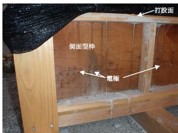
写真-2 側面型枠の電極設置状況
