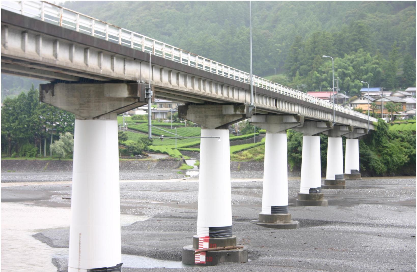
道路橋橋脚の鋼板巻立て補強例
