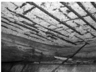
塩害により鉄筋がむき出し
