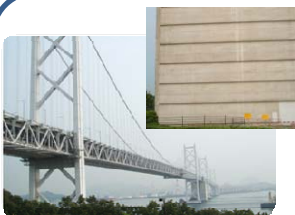
コンクリート橋
