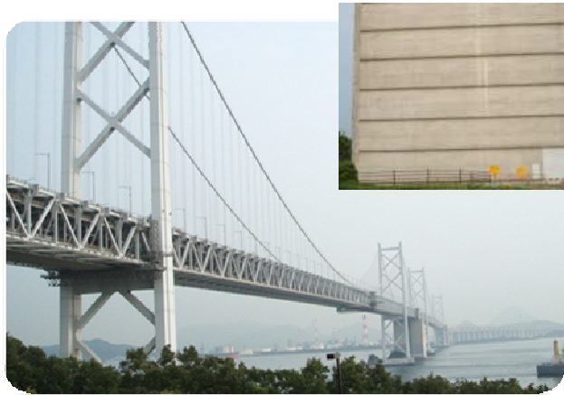
コンクリート橋
