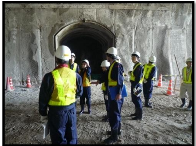
トンネル内部
