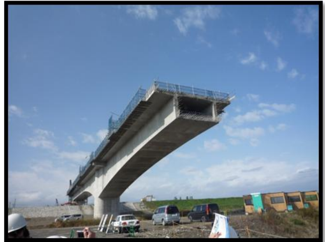
ディビダーク工法による橋梁建設
