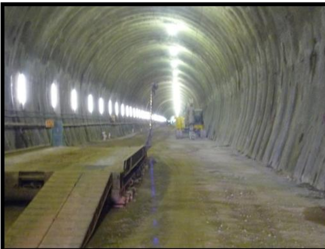
トンネル内部
