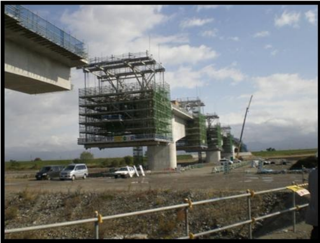
ディビダーク工法による橋梁建設
