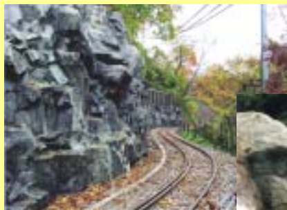
写真上 立山砂防擁壁
