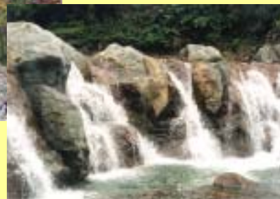
写真下 利根川砂防ダム
