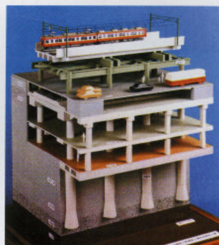
地下街躯体および高架橋アンダーピニング模型
