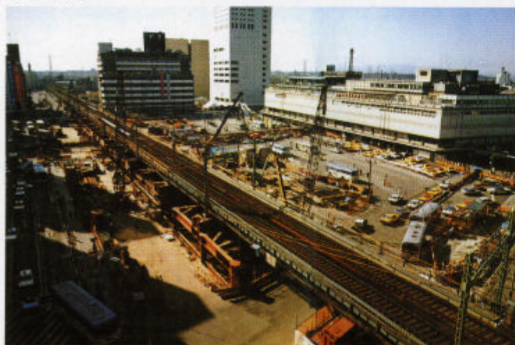
京浜急行高架橋アンダーピニング
