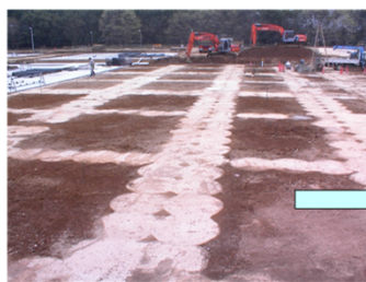
格子状セメント改良壁による液状化の防止
