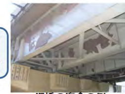
鋼橋の腐食の例
