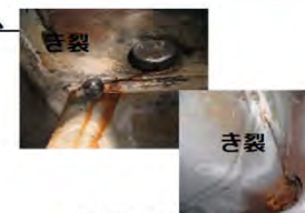
鋼橋の疲労の例
