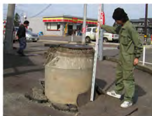
マンホールの浮上り
